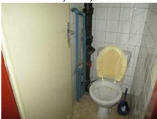
sociální zázemí - ubytovna
