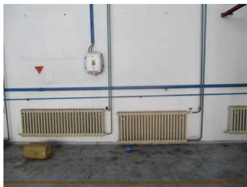
vnitřní prostor hangáru
